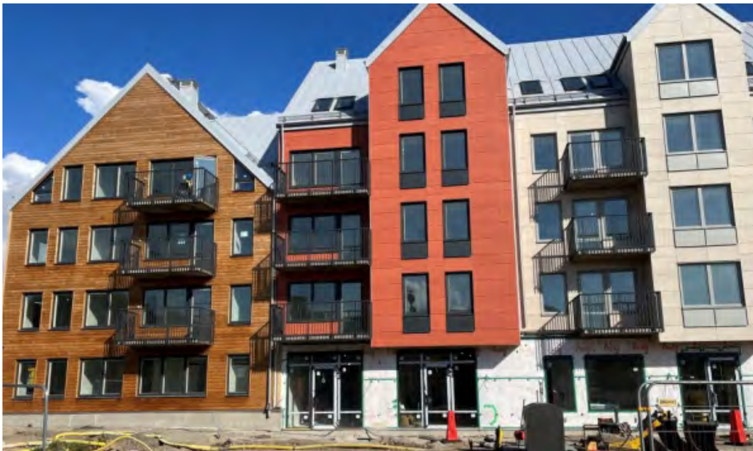
Kvarteret Bonden byggs i den nya stadsdelen Västra Förstaden i Halmstad.
